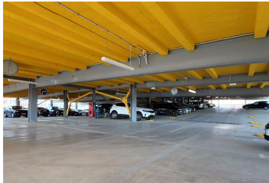
Сборное перекрытие из ЖБ плит
